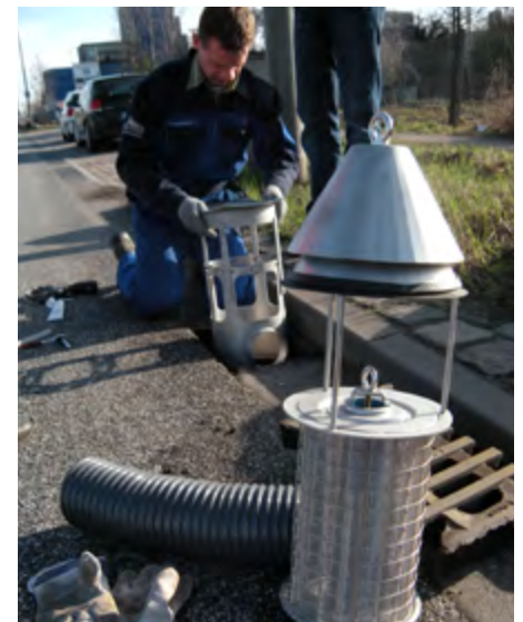
Spezielle Filtersysteme von Funke schützen Kanalisationen vor abgelöstem Mikroplastik
